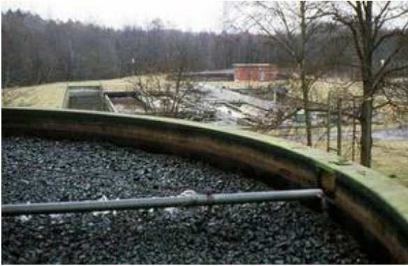
Abbildung 2: Kleinere niedersächsische Kläranlage mit Tropfkörper (1982)
