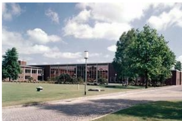
Abbildung 1: Wasserwerk Elze-Berkhof der Stadtwerke Hannover AG (1978)
